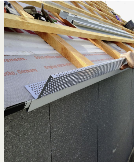
Auf der unteren Ebene der belüfteten Traufkonstruktion montierten die Dachdecker ein Tropfblech und ein Schutzgitter, was eine Hinterlüftung zulässt, unerwünschtes Kleintier aber wirksam abhält.
