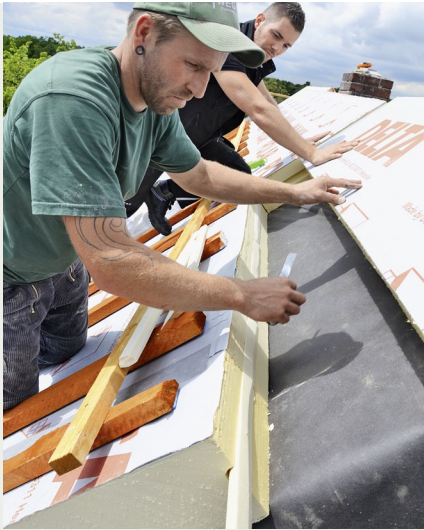
Bei Stößen von Standardplatten mit Plattenzuzschnitten konnte man die Elementnuten mit vorher angefallenen Federabschnitten füllen.
