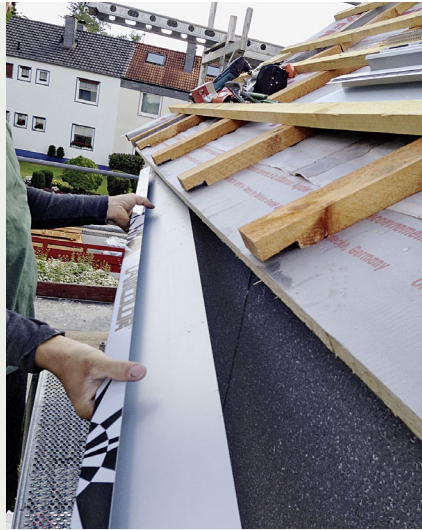
Die neue Traufuntersicht wurde von unten mit der auskragenden Konterlattung verschraubt und mit einem Kanteil aus Aluminiumblech eingefasst.
