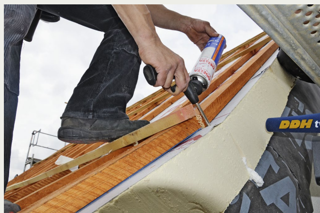
Ausschäumen des durch den Aufschiebling verursachten Knicks in den Dämmplatten
