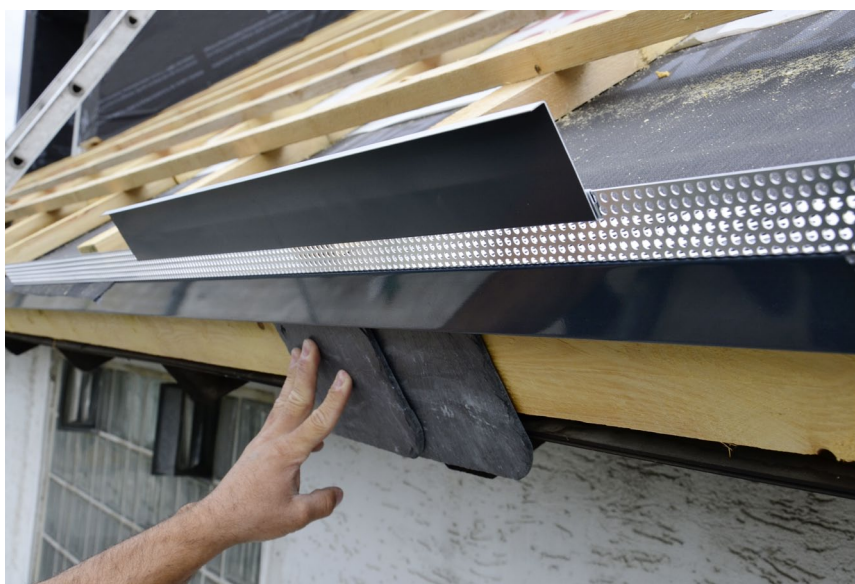
Traufdetail mit Hinterlüftungsebene: Ein Mitarbeiter der Wegner Dachtechnik hält einen Schieferstein als Muster für den Kunden an.
