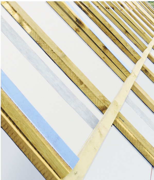
Nageldichtbänder zwischen Konterlatte und Unterdeckbahn sorgen für ein regensicheres Unterdach.
