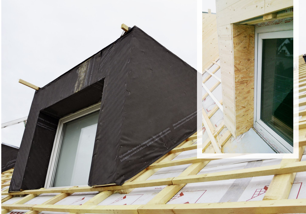
Auch die Gauben erhielten an den Wangen sowie den vorderen Stempeln eine Wärmedämmung aus PU-Platten. Die Schalung dient der späteren Aufnahme der geschraubten Schieferdeckung.
