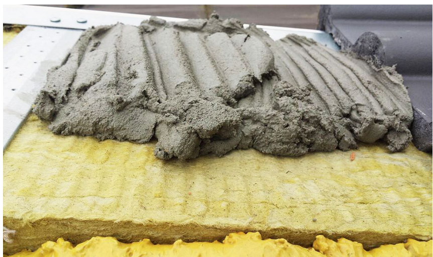
Die ersten beiden Dachsteinreihen verlegte das Wegner-Team gemäß den Brandschutzvorgaben in einem Mörtelbett. Zusätzlich wurden die Dachsteine mechanisch fixiert.
